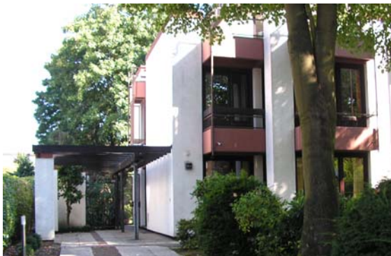
Carport, das sich zurücknimmt und sich dem Stil des Hauses anpasst.
