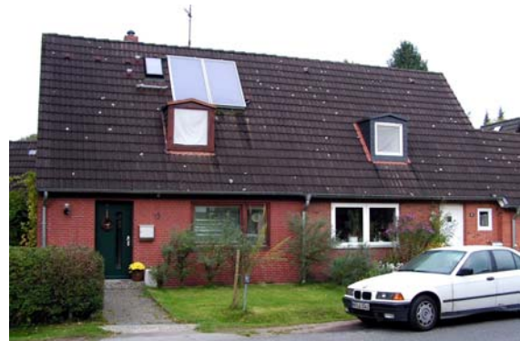
Das Gebäude verschwindet optisch hinter dem Sammelsurium: Gaube, Sonnenkollektoren und kleinem Dachflächenfenster
