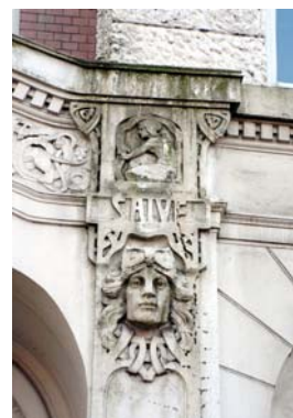
Detail einer Jugendstilfassade
