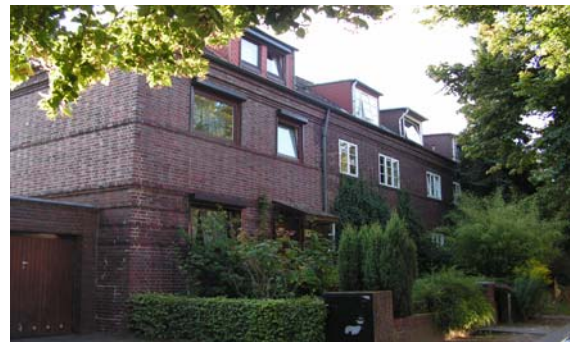
Reihenhäuser am Basselweg (Stellingen)
