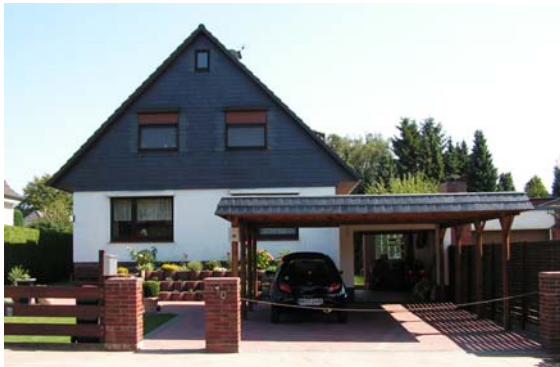
Hier wurde nachgerüstet: Die ursprüngliche Garage versteckt sich hinter dem „übergroß dimensionierten“ Carport, hinter dem auch ein Viertel des Hauses verschwindet.
