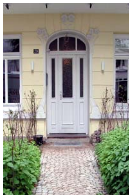
schlichter Eingangsbereich eines Mehrfamilienhauses
