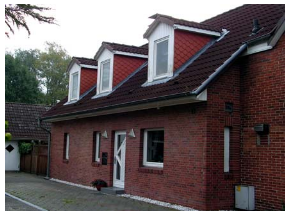
Das Volumen der Gauben steht in einem ungünstigen Verhältnis zu dem Gesamtgebäude. Das Erdgeschoss wirkt durch sie erdrückt.
