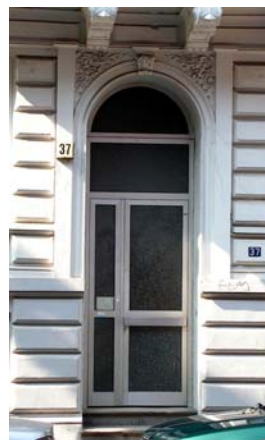
Die ursprünglichen Türen wurden ersetzt. Metallprofile und übermäßige Glaseinsätze nehmen dem Eingangsbereich das Gewicht.
