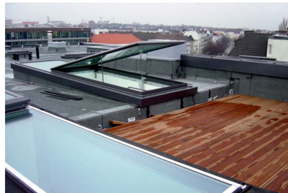
Dachausstieg, der ausschließlich dem Ausstieg auf die eingesenkte Dachterrasse dient. Von der Straße wird er nicht wahrgenommen.
