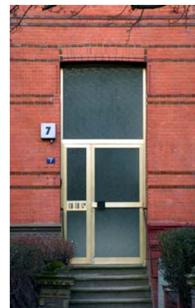
Die ursprünglichen Türen wurden ersetzt. Metallprofile und übermäßige Glaseinsätze nehmen dem Eingangsbereich das Gewicht.
