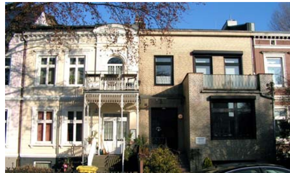
Unterschiedliche Fassadenerneuerungen: stilgerechte Erneuerung der Fassade einerseits und Verkleidung der Fassade und damit Verlust der interessanten Fassadenelemente andererseits
