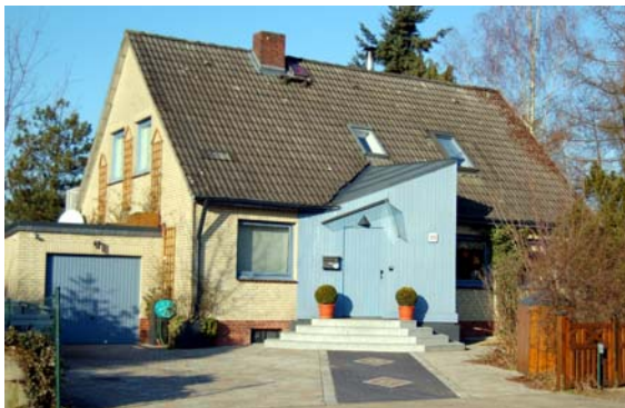
Eingangstür schlecht wahrnehmbar, trotz Anbaus und Treppe
