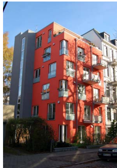
An einer schwierigen Stelle zwischen gründerzeitlicher Bebauung und 1950er Jahre Zeilen realisiert – ein deutlicher Abschluss, der die unterschiedliche Nachbarschaft akzeptiert.
